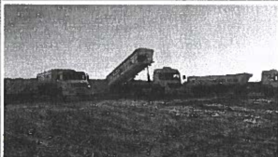
Foto 15: Camiones con las tolvas para el transporte de escorias dentro de la celda.
