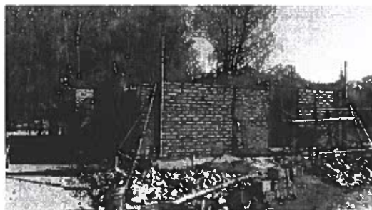
Foto. Avance de los trabajos en el nuevo Club La Planta
