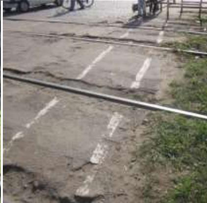
Solado deteriorado en sendero peatonal de Paso a Nivel punta ascendente de Estación.
