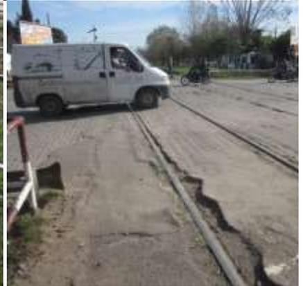
Pavimento deteriorado entre rieles de Paso a Nivel Vehicular punta ascendente de Estación.
