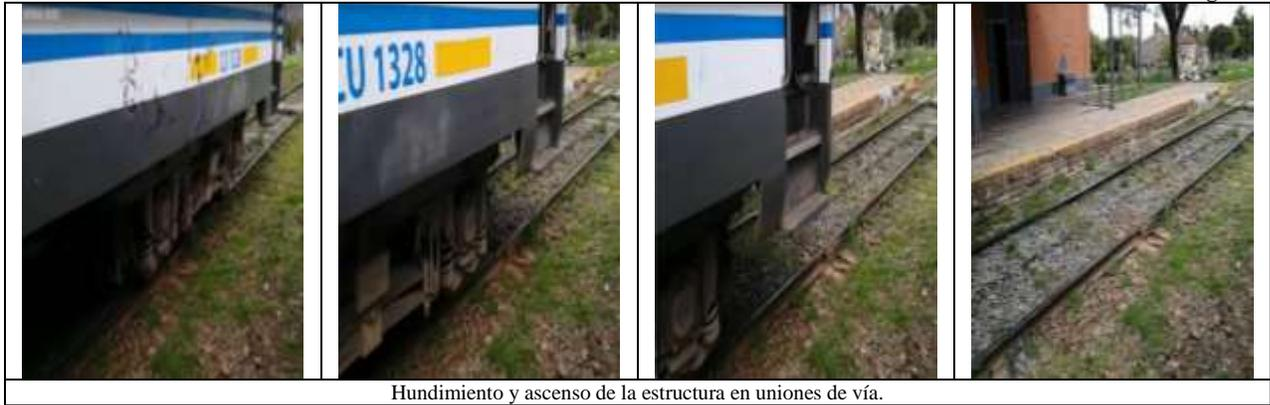
Hundimiento y ascenso de la estructura en uniones de vía.
