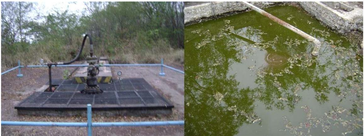
*Izq.:* Pozo 35, en funcionamiento correctamente sellado con válvulas de presión. *Der.:* Pozo JCa 6, no sellado.
