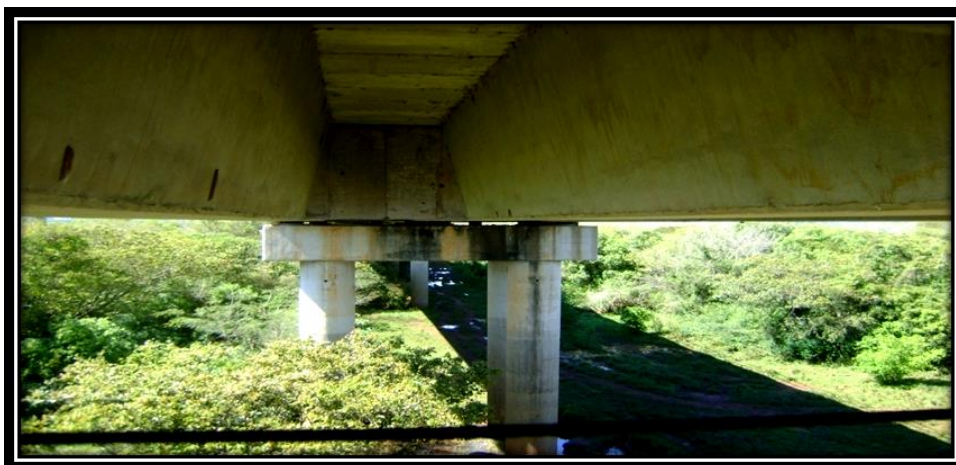
Foto 13.- Vista de Viga Cajón – Viga Transversal y Apoyos
