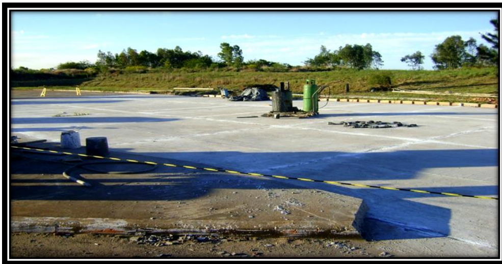
Foto 16 - Sector de circulación con losas nuevas
