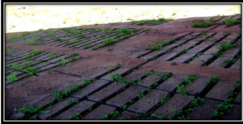
Foto 12.- Talud de protección de Estribos – Lado Br.
